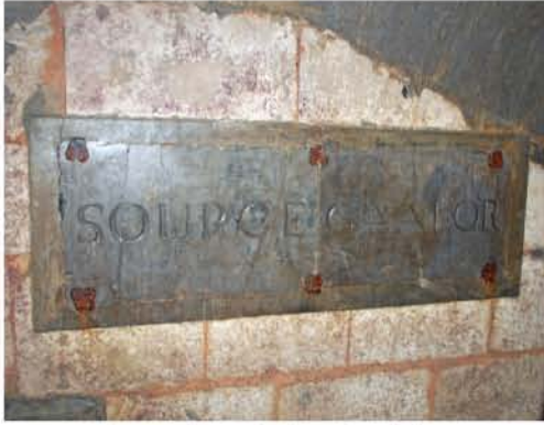
Cette ancienne plaque indicatrice de la source se trouvait au fronton d'un petit édicule qui la surmontait. Cet édicule a été dessiné par Laquerrière avant sa disparition.
